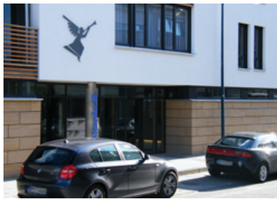
EINGANG HAUS DER DIAKONIE IN GOCH
